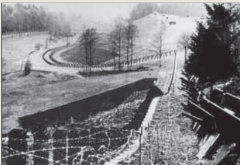
Linie objektů těžkého opevnění doplňovaly soustavy protitankových i protipěchotních překážek. Zde jsou zachyceny u srubu K-35 nad Mladkovem v Orlických horách.
